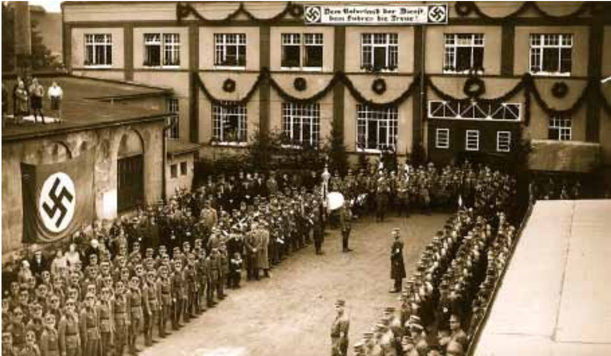
Einweihung des Reichsarbeitsdienst-Stützpunktes Langwiesener Straße 16 im Oktober 1934. Der paramilitärisch organisierte Dienst sollte die hohe Arbeitslosigkeit zu Beginn des NS-Regimes verringern; mit Beginn des II. Weltkrieges wurde er „Bautruppe der Wehrmacht“.
